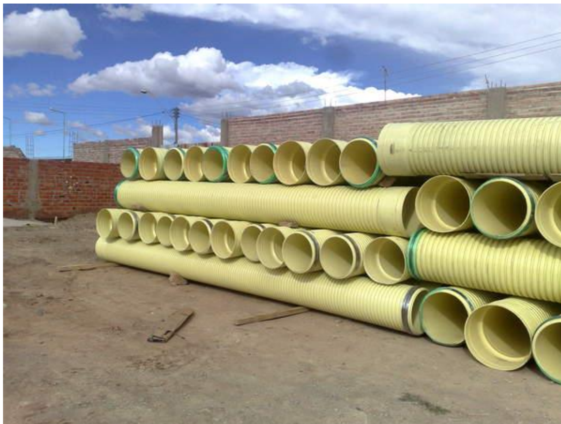
Figura 13. Estiba permanente de tubería Novafort
