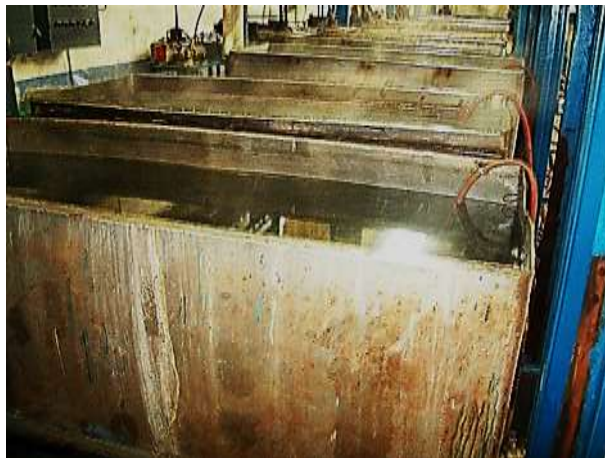
Figura 10. Tanque de tratamiento
