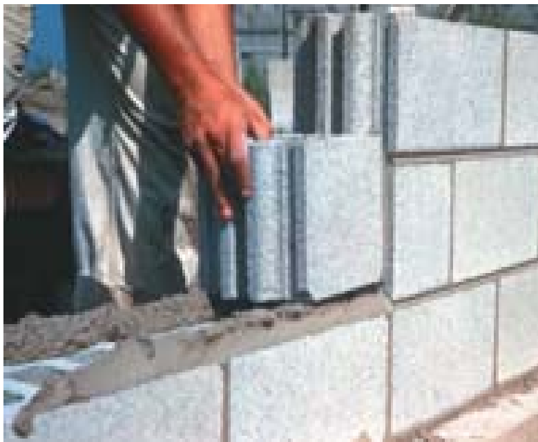
Figura 8 Conjunto cemento-mortero-unidad de mampostería
