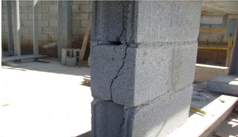
Figura 27 Falla típica ensayo a compresión prisma
