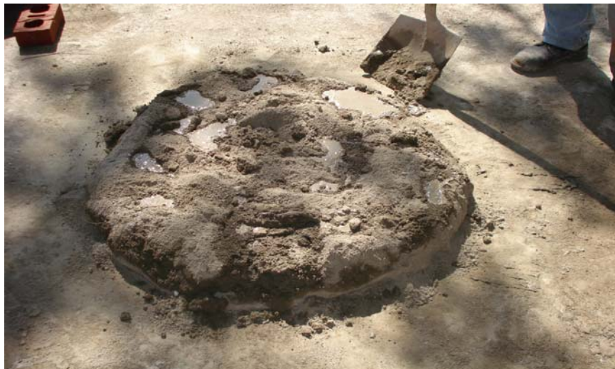
Figura 1 Elaboración de mortero de mampostería en obra
