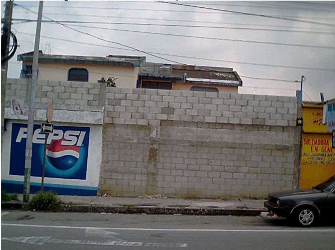
Figura 18. Fotografías de estructuras de mampostería.
