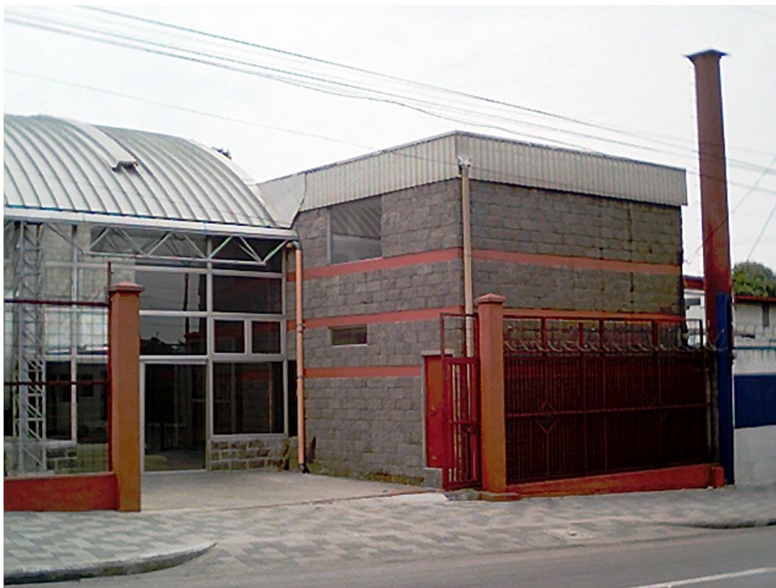
Figura 20 Fotografías de estructuras de acero.
