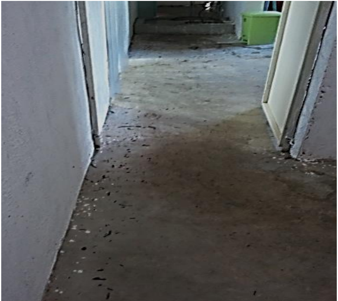
Figura 11. Pasillos circundantes en toda la planta
