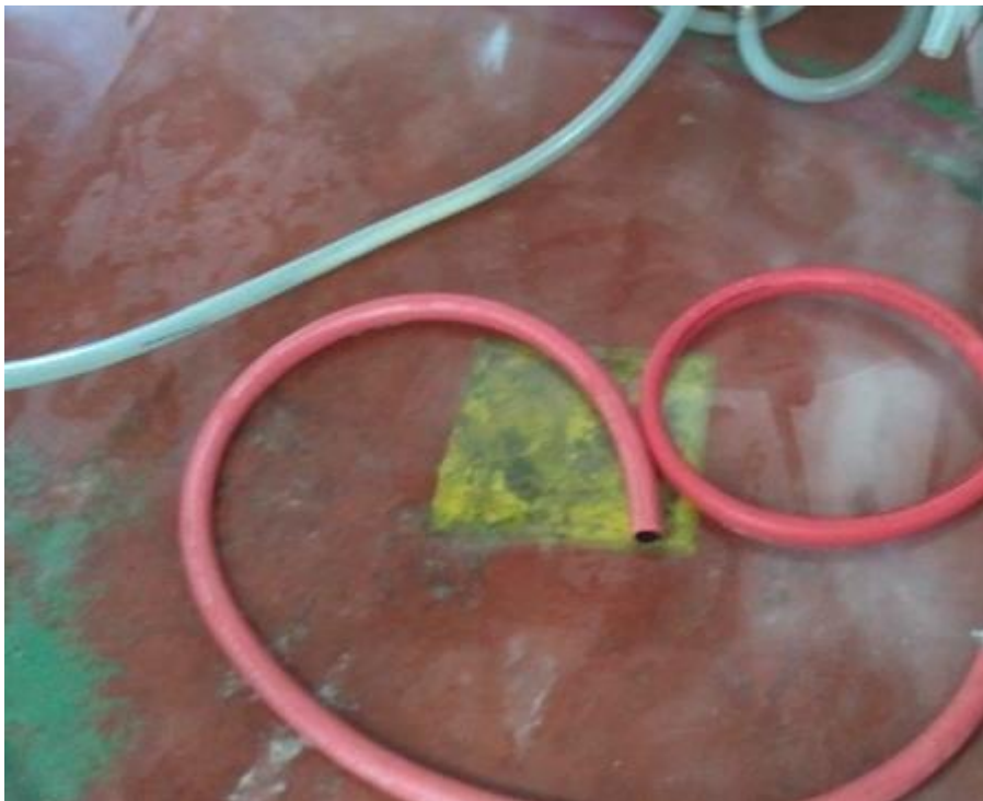
Figura 10. Cemento alisado con pintura epóxica
