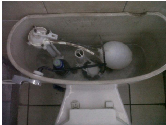
Figura 36. Colocación de pachones en los inodoros
