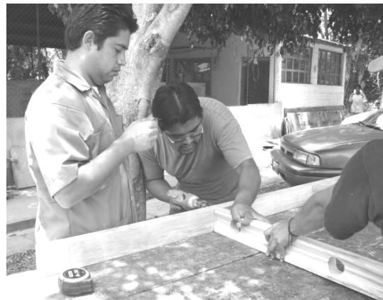
Figura 36. Armado de moldes
