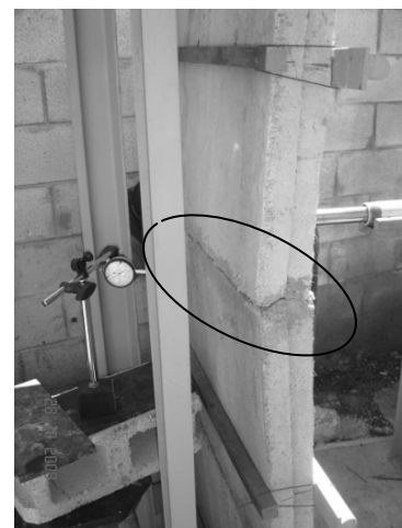
Figura 126. Falla en junta central panel a carga de flexión
