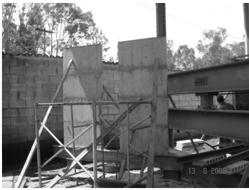
Figura 59. Paneles para carga a compresión
