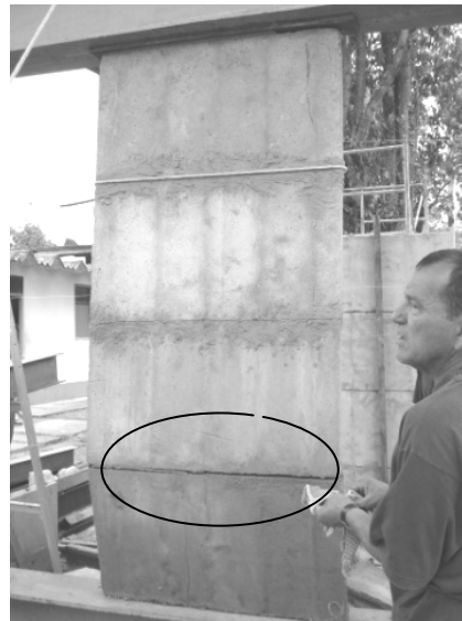
Figura 114. Panel deflectado 2 ensayo a compresión
