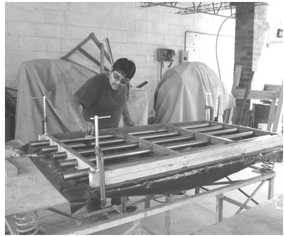
Figura 30. Limpieza máquina vibradora
