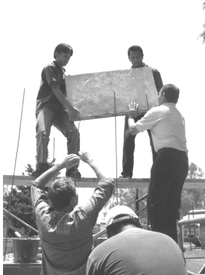
Figura 53. Levantamiento de bloques a mano
