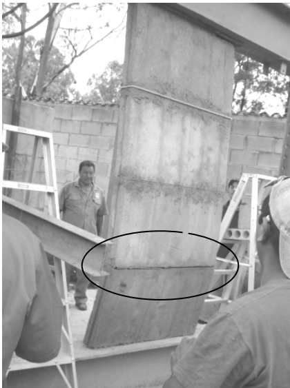
Figura 113. Panel deflectado 1 ensayo a compresión
