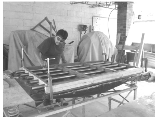
Figura 40. Aplicación de desencofrante
