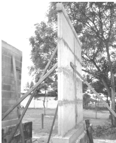
Figura 78. Muro de paneles de bloques fibrorreforzados para ensayo a carga horizontal
