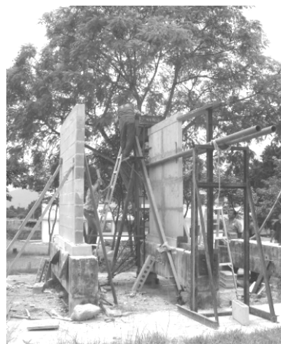
Figura 79. Armado en sitio de aparato para ensayo a carga horizontal
