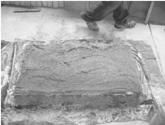
Figura 47. Curado de bloques fibrorreforzados
