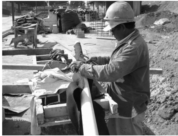
Figura 52 Colocación de Geodren
