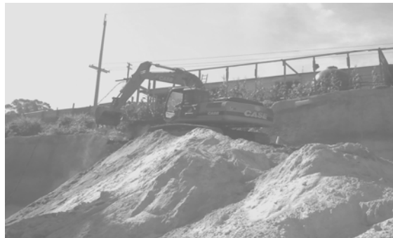
Figura 34 Elaboración de rampa
