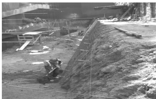
Figura 43 Colocación de electro malla
