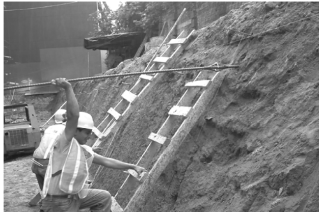
Figura 40 Colocación de la varilla del anclaje
