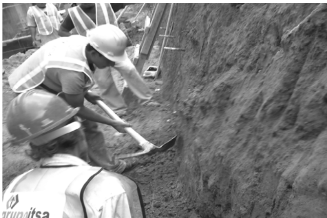
Figura 36 Tallado de talud a mano
