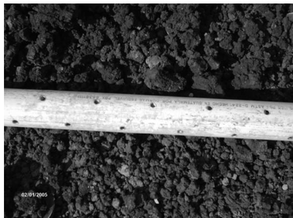
Figura 51 Tubo perforado
