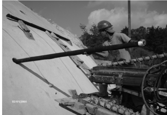
Figura 54 Colocación de drenajes
