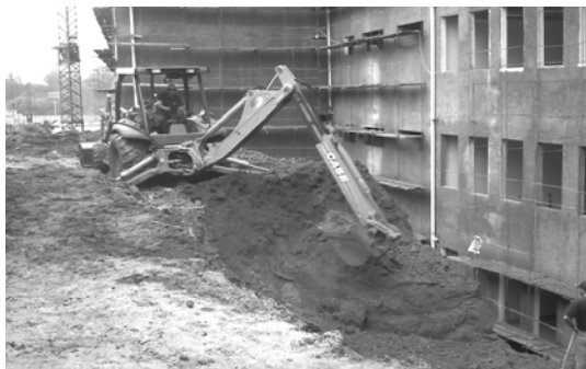
Figura 35 Corte de talud por etapas
