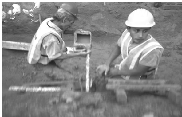
Figura 41 Fundición de anclajes
