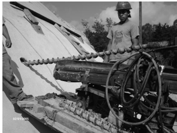
Figura 53 Perforación para drenajes
