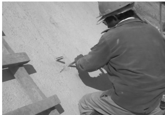
Figura 47 Preparación de superficie para colocar platina
