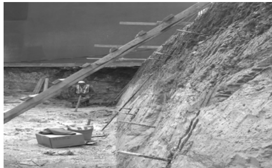
Figura 42 Anclajes fundidos
