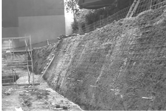
Figura 44 Electro malla fijada en el talud
