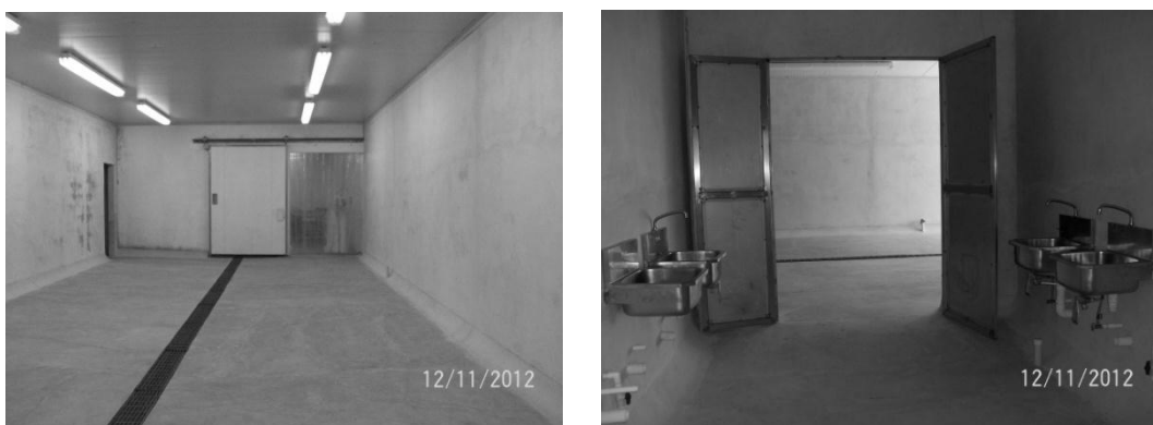
Figura 5. Puertas del área de proceso y entrada principal del personal
