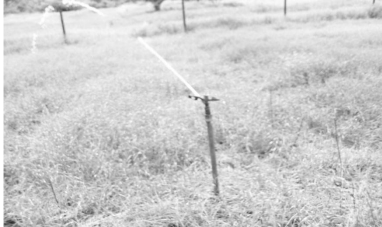
Figura 27. Aspersores de agua servida
