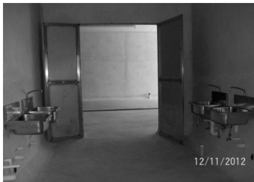
Figura 11. Lavamanos afuera del área de proceso
