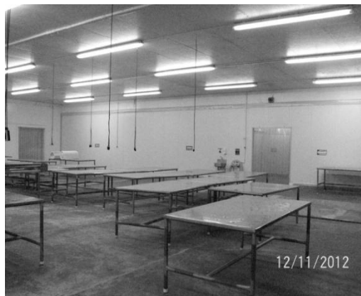
Figura 4. Piso, paredes y techo de la sala de proceso
