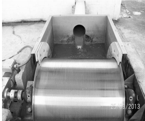
Figura 25. Filtro de aguas servidas
