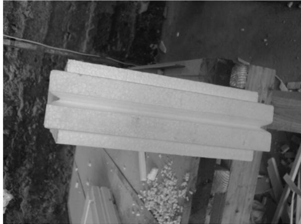
El núcleo de poliestireno se le reviste en sus áreas laterales de una pulgada de concreto, fundido artesanalmente ayudado con una formaleta, como se muestra en la siguiente fotografía.
