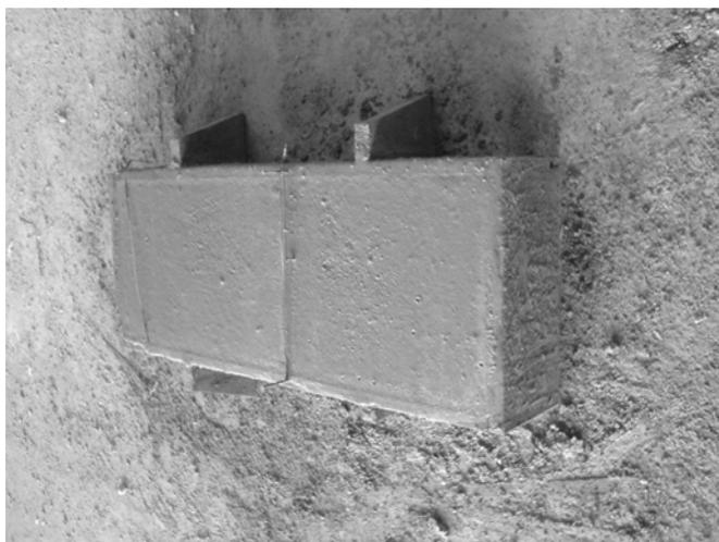
Estos bloques poseerán una pastilla de concreto en los extremos con dientes en su área transversal para una mejor adherencia con el poliestireno.
