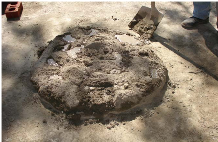
Figura 4 Mezcla mortero de mampostería
