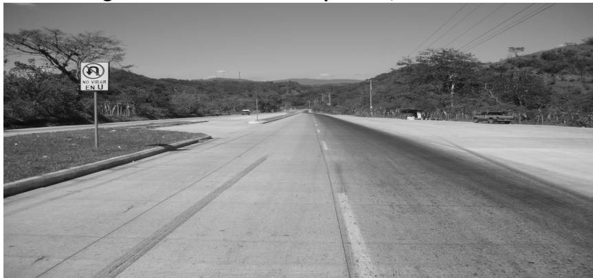
Figura 75. Pulimento de superficie, CA-02 km.44
