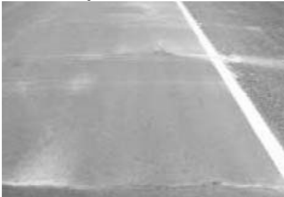
Figura 33. Afloramiento de finos
