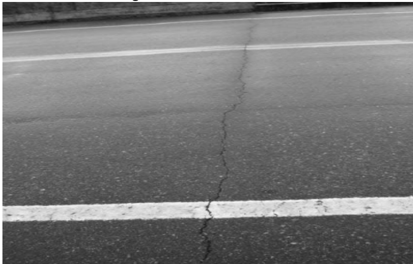
Figura 24. Fisura transversal
