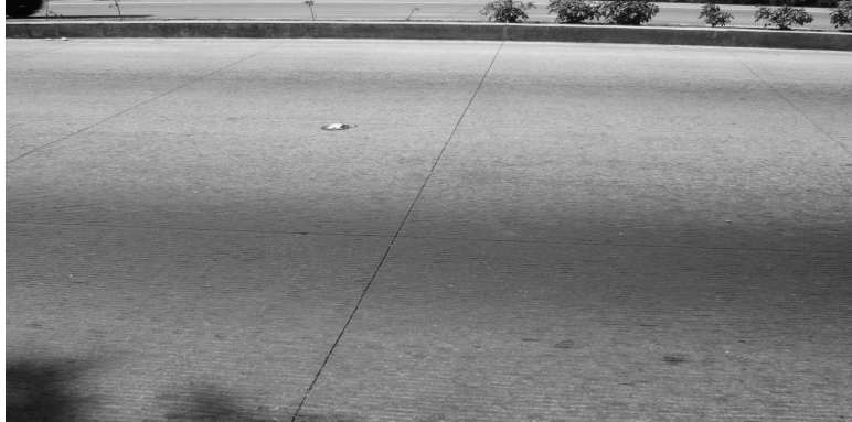
Figura 64. Pulimento de superficie, RN-10 km. 32.8
