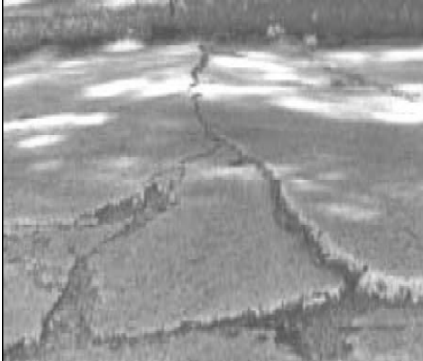
Figura 19. Levantamiento de losa
