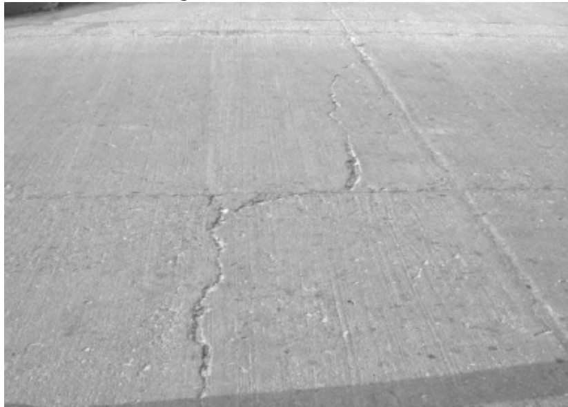
Figura 30. Fisura transversal
