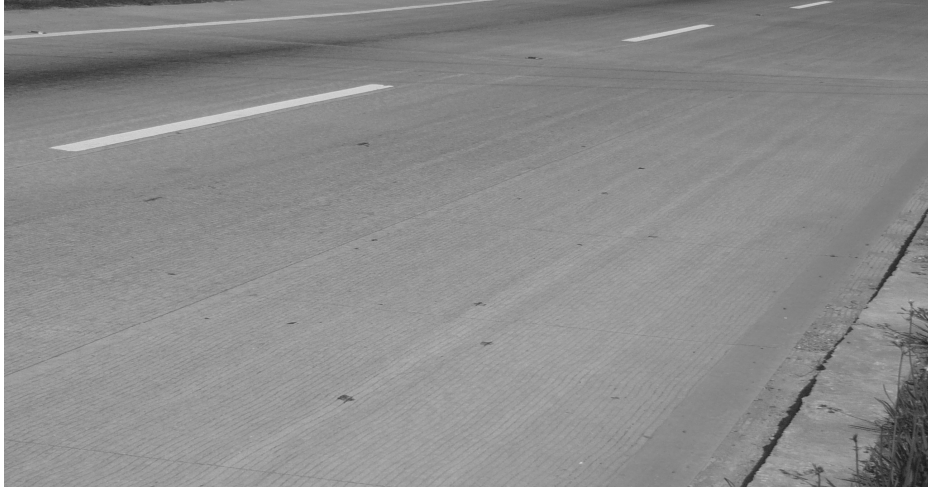
Figura 60. Pulido de Superficie a nivel bajo pavimento rígido, RN-10 km. 30
