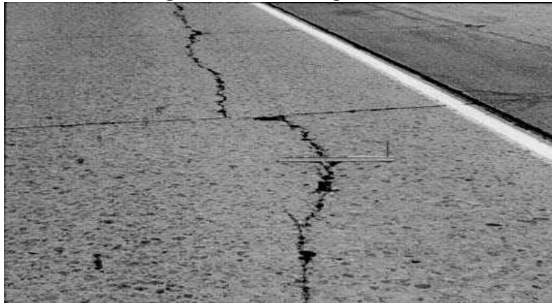
Figura 29. Fisura longitudinal
