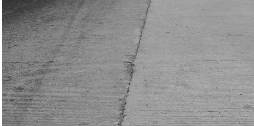
Figura 74. Despostillamiento de junta, CA-02 km.44
