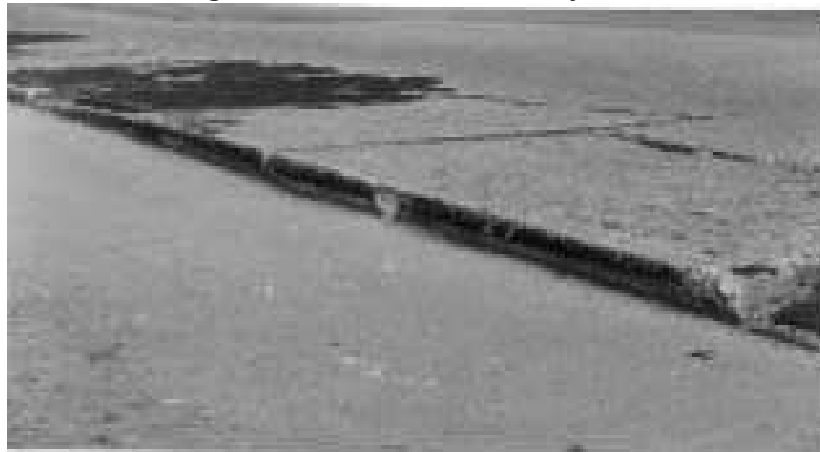
Figura 21. Escalonamiento de juntas
