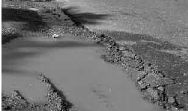
Figura 3. Desintegración de bordes
