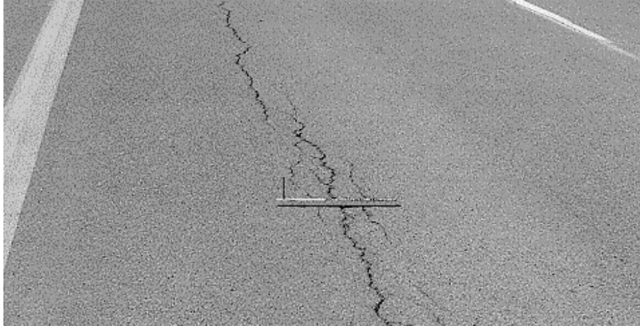
Figura 25. Fisura longitudinal
