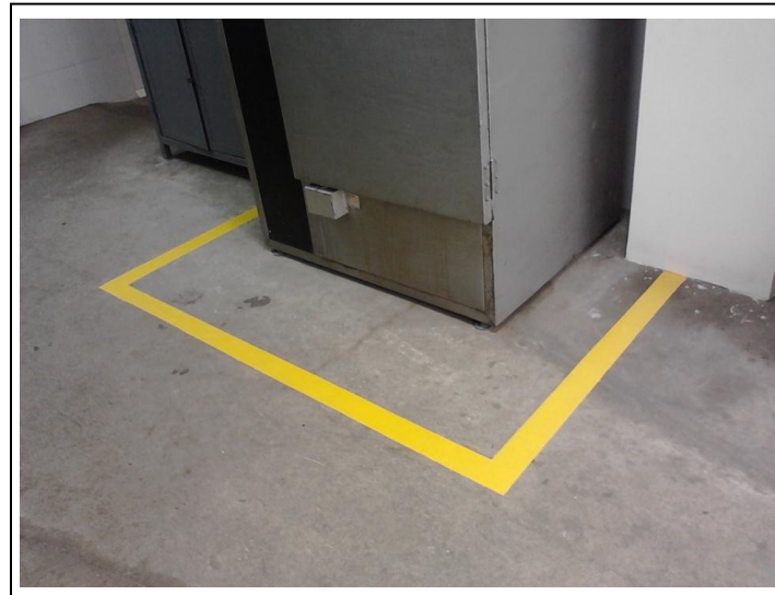
Figura 18. Señalización Área de Máquinas
