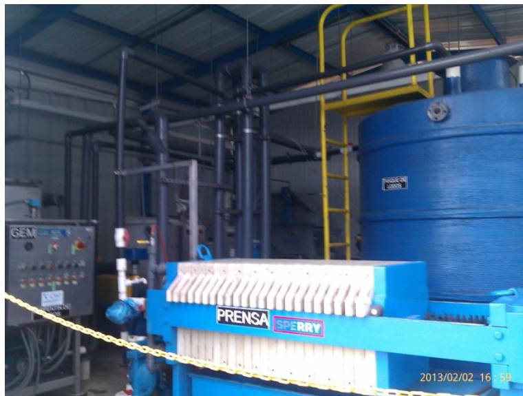
Fuente: Planta Panificadora.
