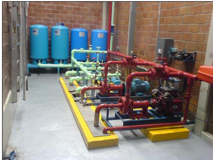
Figura 9. Depósito de agua
