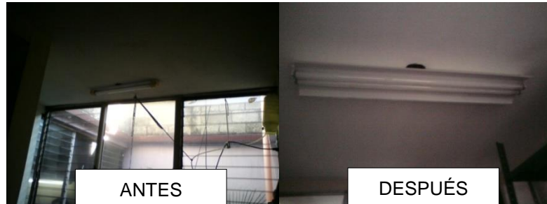
Figura 42. Cambio de luminaria en Área de Empaque
