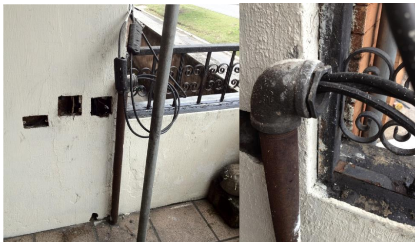
Figura 19. Cableado eléctrico arreglado
