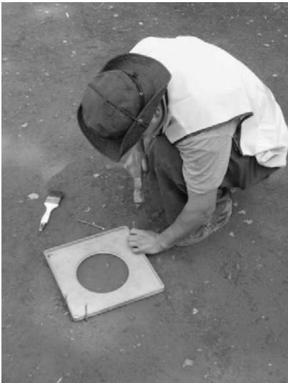
Figura 11. Colocación de la placa base
