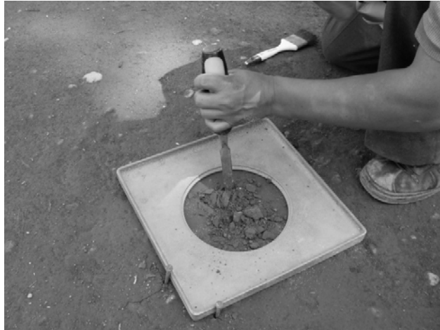
Figura 14. Excavación del agujero
