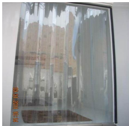
Figura 12. Cortinas plásticas para cuarto frío
