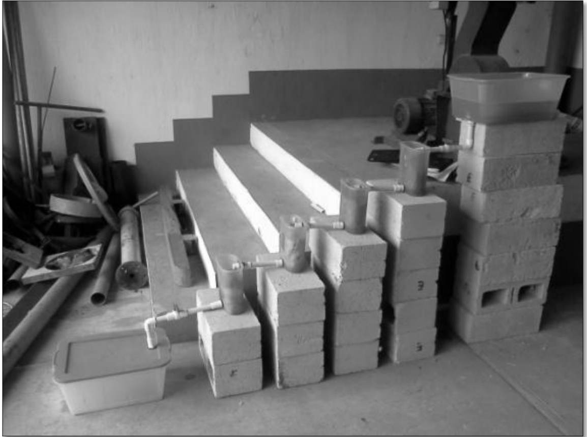
Figura 125. Nuevo sistema ahorrador de agua
