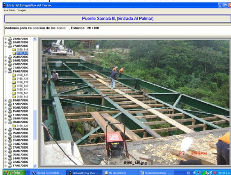
Figura 26. Colocación de armadura de refuerzo sobre la losa acero para la fundición del primer tramo de piso de rodadura.
