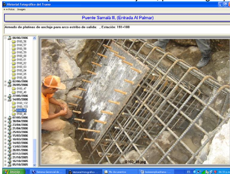
Figura 22. Muro de concreto armado totalmente fundido con sus platinas laterales; y Anclaje de una viga principal en forma de arco, lado derecho.
