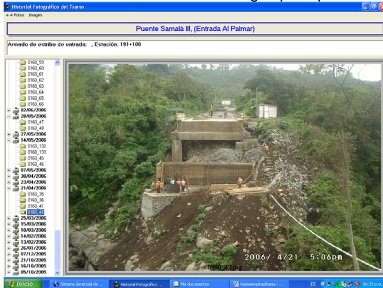
Figura 21. Unido al armado de los aproches se instalan las platinas de acero, para la fundición conjunta, para las vigas principales.
