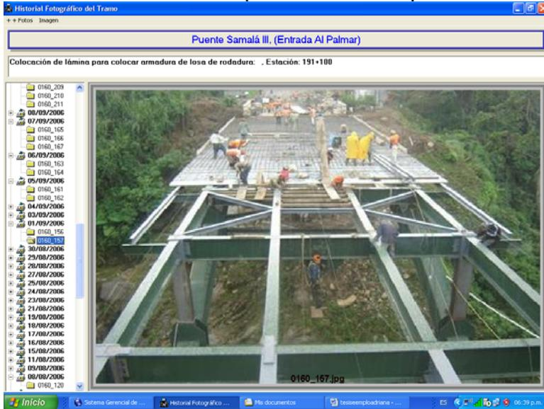
Figura 27. Piso de rodadura del puente totalmente fundido e instalación de postes de acero para la colocación de malla de protección lateral.
