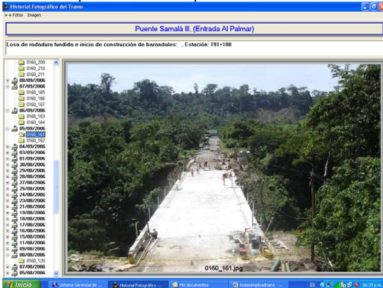
Figura 28. Colocación de armadura de acero, formaletado y fundición de banquetas, para el paso peatonal sobre el puente.
