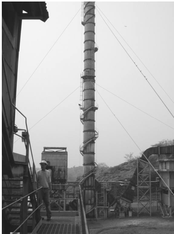
Figura 7. Chimenea del fundidor y del horno reductor
