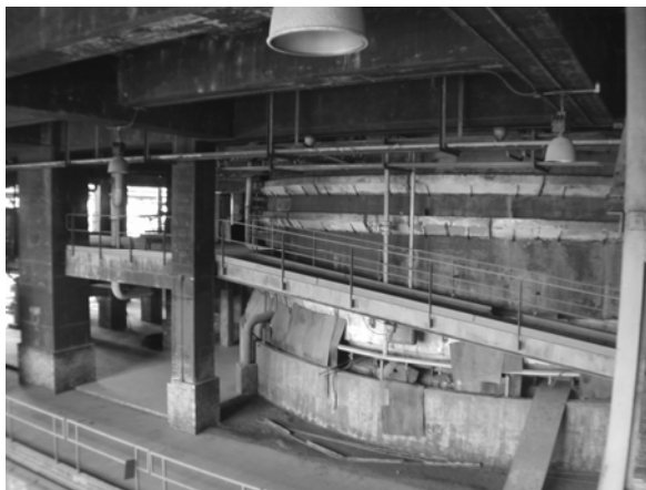
Figura 5. Vista actual del fundidor eléctrico
