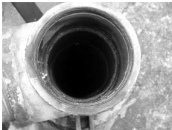
Figura 16. Brocal del pozo 2, División de Servicios Generales
