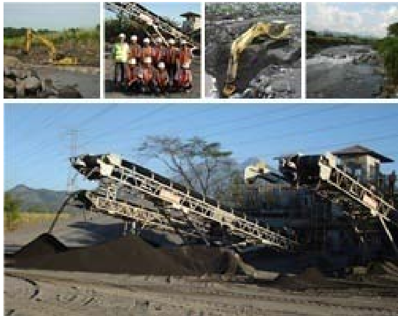
Figura 1. Extracción de material y planta trituradora
