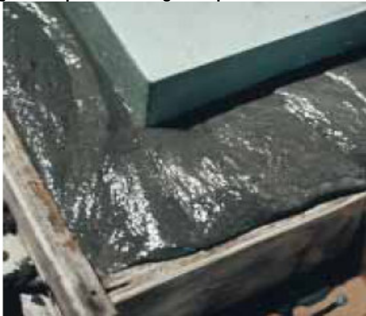
Figura 4 Aplicación de grout epóxico en cimentación
