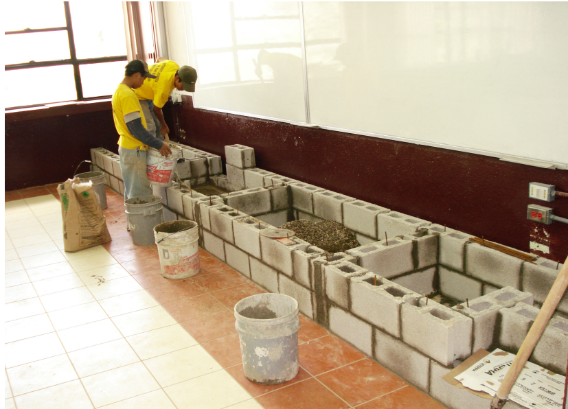
Figura 2 Construcción con mampostería no reforzada
