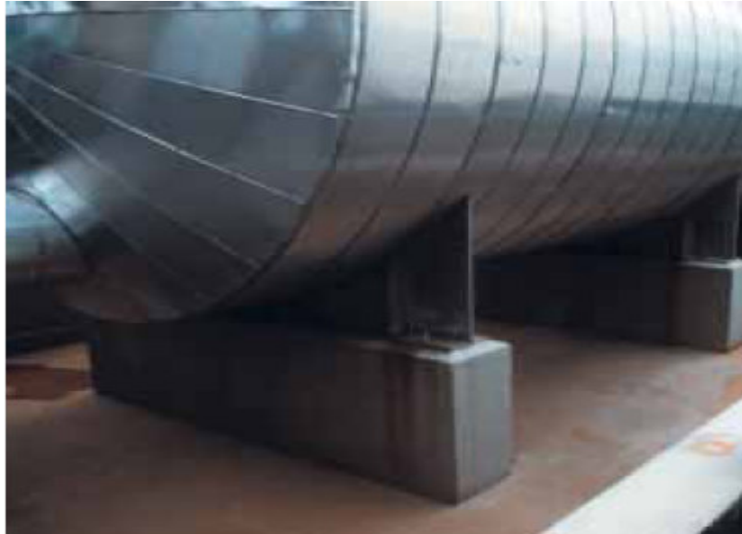
Figura 5 Aplicación de grout epóxico en anclaje de equipo
