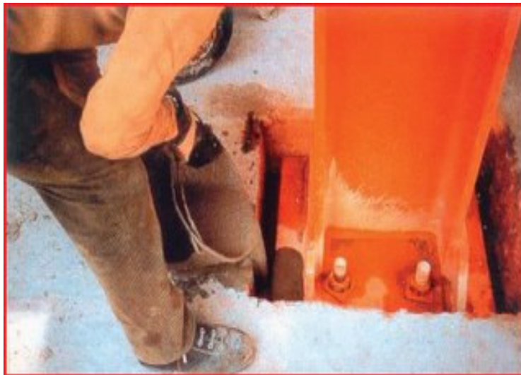
Figura 3 Aplicación de grout para uniones de pedestales
