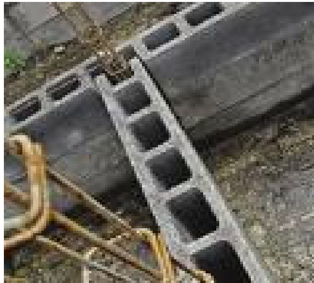
Figura 1 Arreglo de unidades de mampostería y colocación de refuerzo
