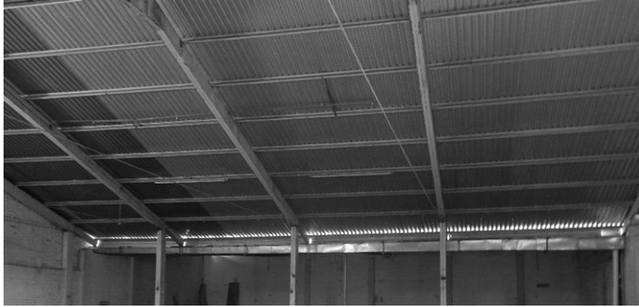
Figura 16. Techo de la bodega
