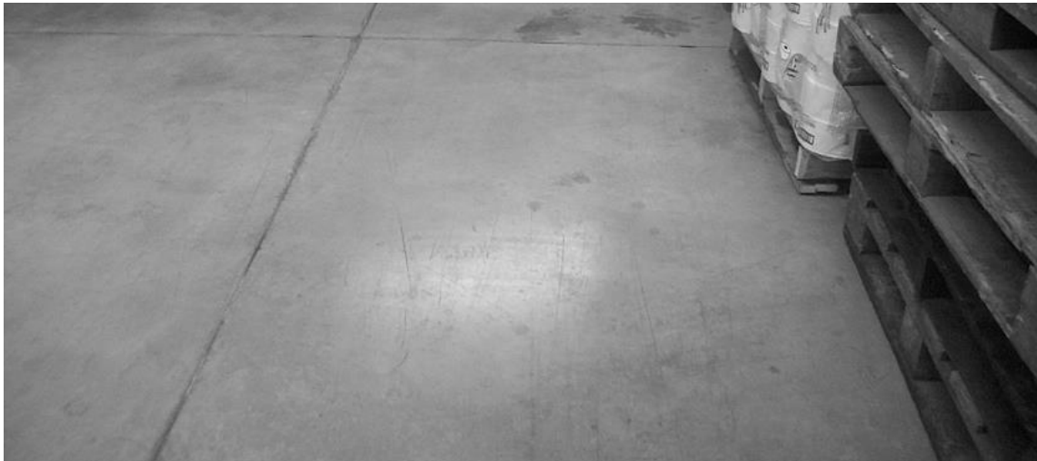
Figura 18. Piso de la bodega
