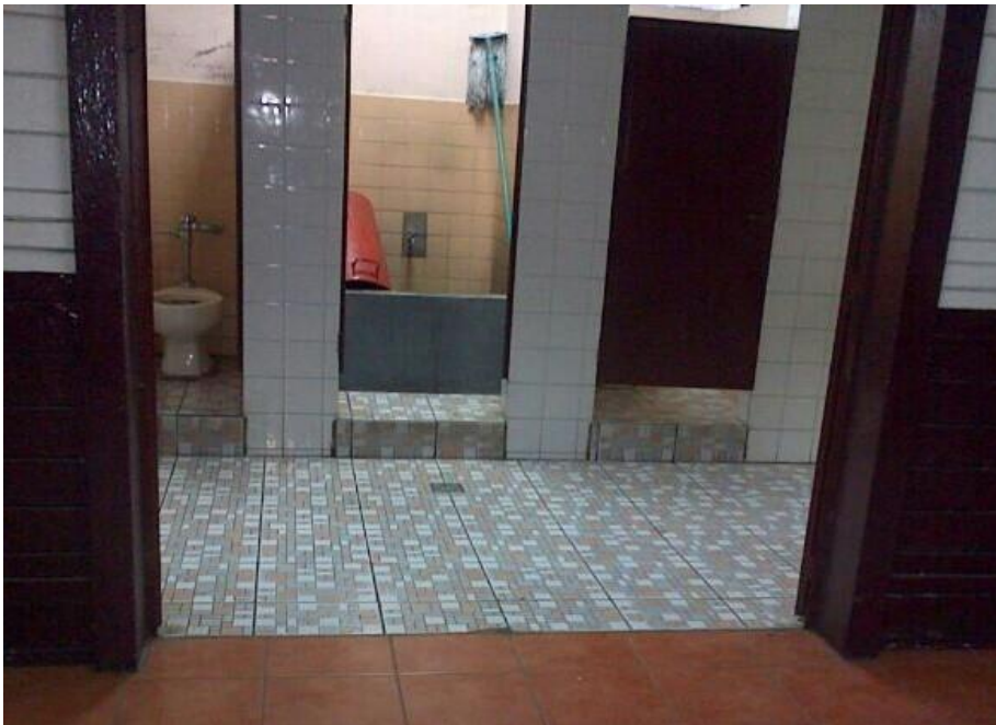
Figura 16. Sanitarios para hombres del edificio T-3
