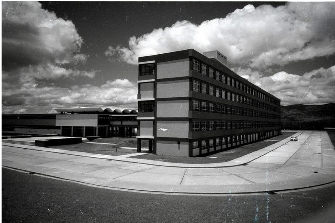
Figura 4. Construcción de edificio T-3 de la Facultad de Ingeniería
