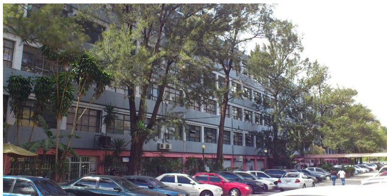
Figura 10. Área de estacionamiento del T-3
