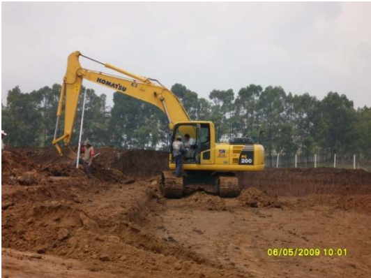
Figura 20. Excavadora Komatsu PC200 en corte de calles
