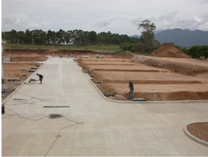
Figura 29. Pavimento terminado en el proyecto Los Jardines
