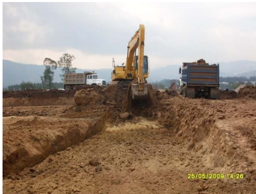
Figura 17. Calle cortada con subrasante conformada
