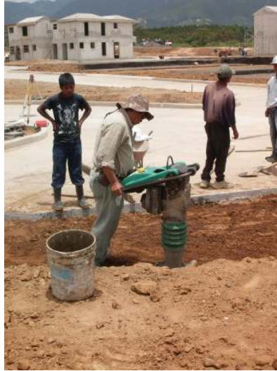
Figura 23. Compactación de zanjas con compactadora manual
