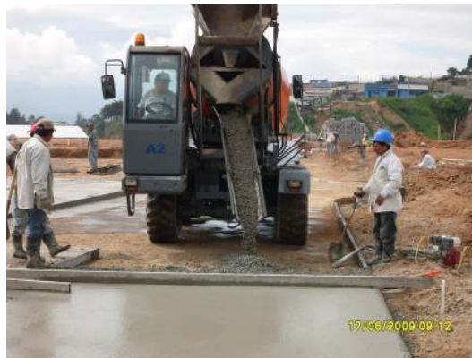
Figura 28. Acabado en pavimentos
