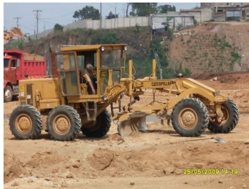
Figura 24. Motoniveladora CAT 120H conformando bases y subrasantes
