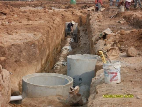
Figura 18. Construcción de pozos de visita para el sistema de drenajes
