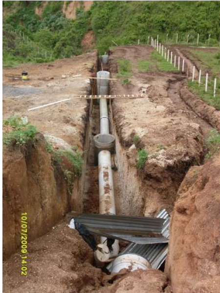
Figura 32. Construcción de dissipador de energía del desfogue de drenajes
