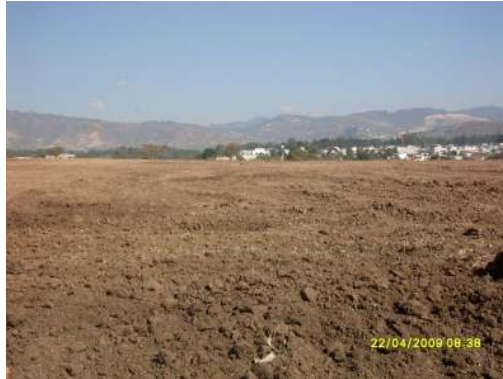
Figura 12. Remoción de capa vegetal
