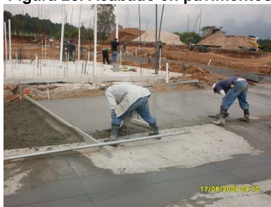
Figura 28. Acabado en pavimentos
