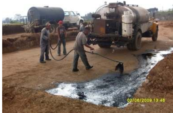
Figura 27. Fundición en pavimentos de concreto con autohormigonera
