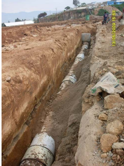
Figura 21. Instalación de tubos en línea central de drenajes
