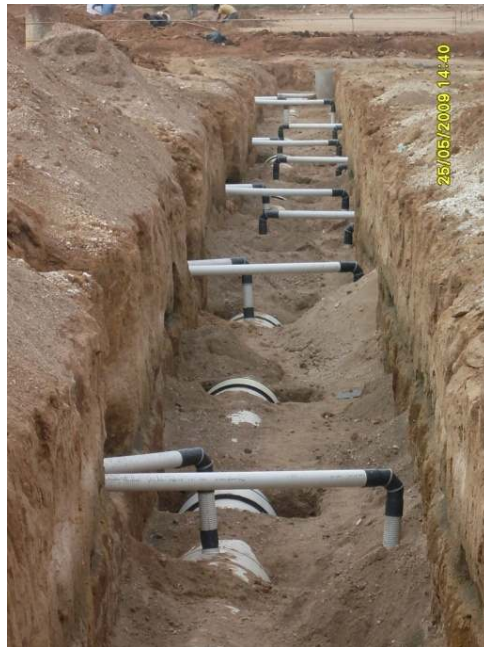
Figura 22. Instalación de silletas para drenajes
