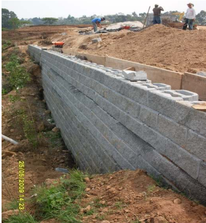
Figura 19. Construcción de muro de contención de block segmentado
