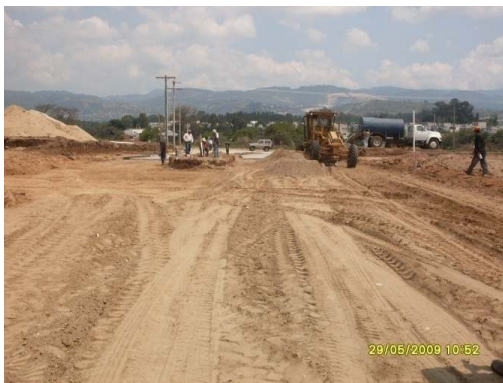
Figura 17. Calle cortada con subrasante conformada
