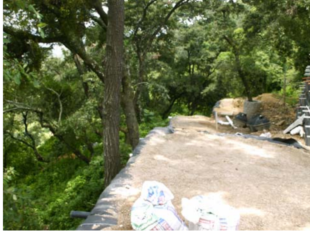
Vegetación del talud en su zona más empinada
