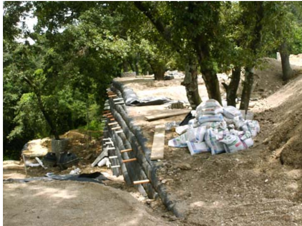
Rampa para área de descanso
