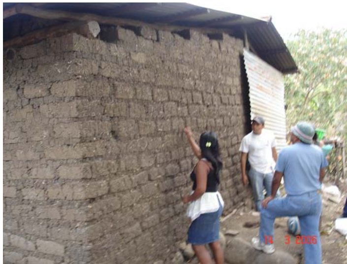
Figura 2. Ejemplo de las condiciones de una vivienda de adobe en la aldea El Sillón, municipio de Yupiltepeque, departamento de Jutiapa, Guatemala.
