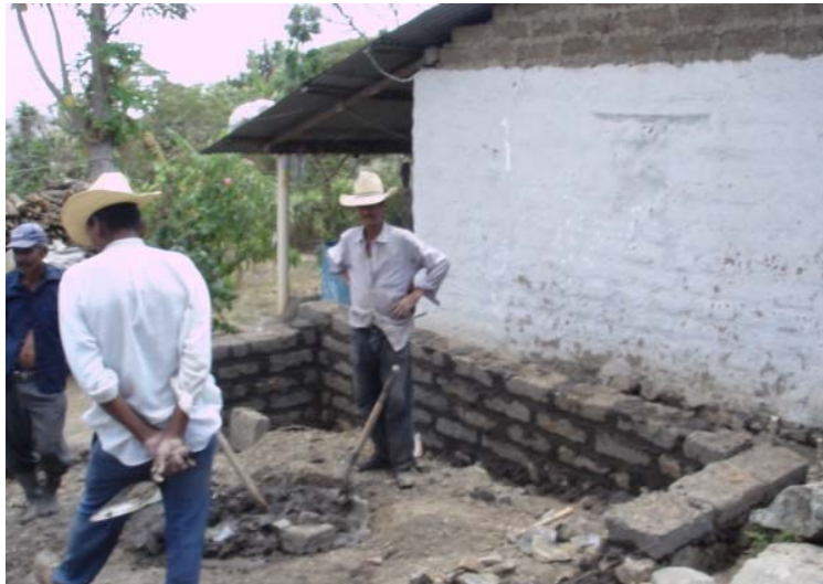
Figura 13. Construcción de viviendas de adobe en la aldea “El Sillón”, municipio de Yupiltepeque, departamento de Jutiapa, Guatemala.
