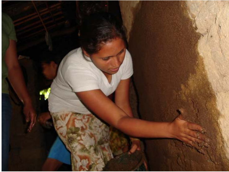
Figura 24. Mujeres haciendo la aplicación de los revestimientos.
