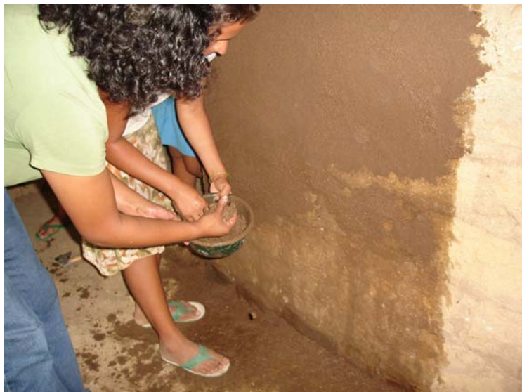
Figura 23. Aplicación de los revestimientos con las manos por las mujeres de la comunidad.
