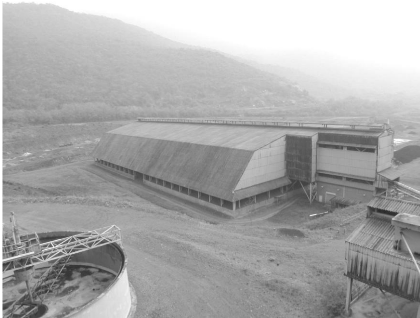
Figura 3. Vista actual del edificio de almacenamiento de mineral seco, El Estor, Izabal.
