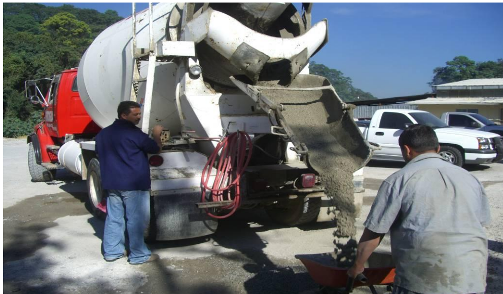
Figura 9 Fundición de concretos evaluados
