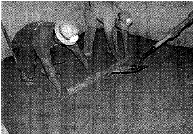
Figura 49. Nivelación de la mezcla ya compactada
