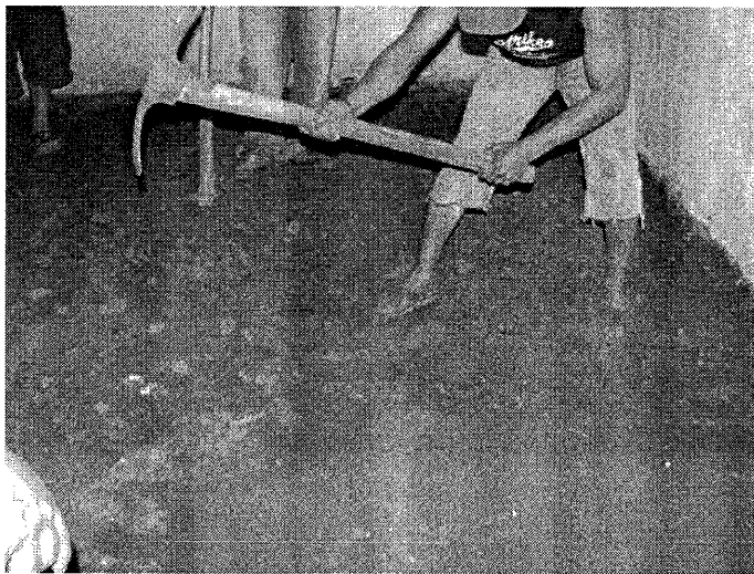
Figura 40. Limpieza y preparación del terreno
