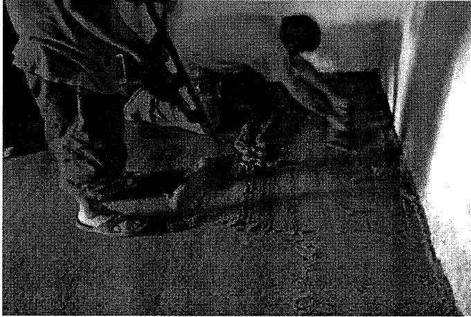
Figura 52. Aplicación de segunda capa
