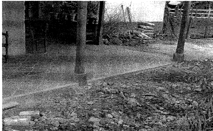
Figura 4. Piso de cemento líquido, existente en aldea El Tule
