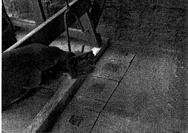
Figura 34. Desprendimiento de la placa con el acabado
