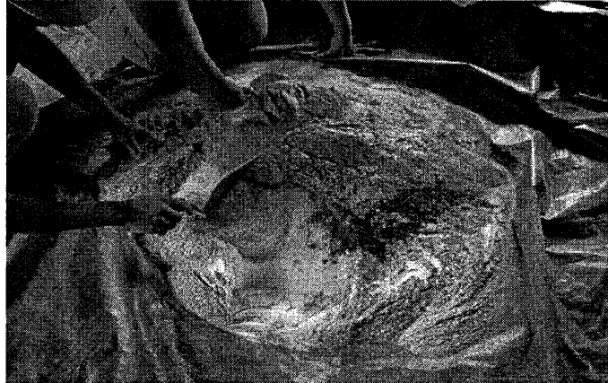
Figura 54. Preparación de material para la capa final de acabado
