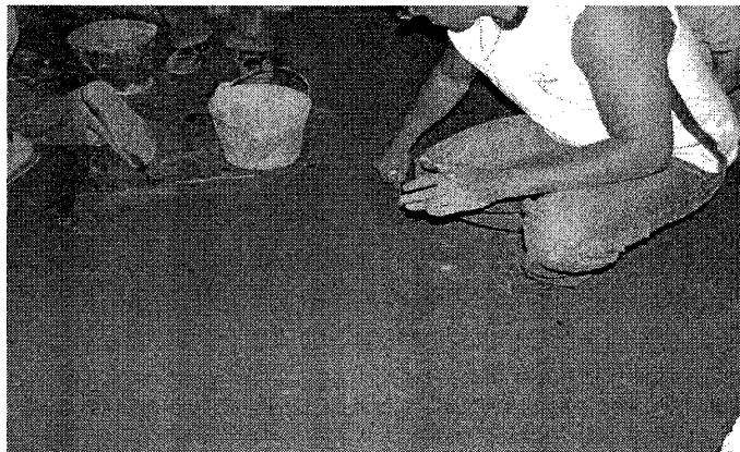
Figura 55. Aplicación de la tercera capa, acabado final
