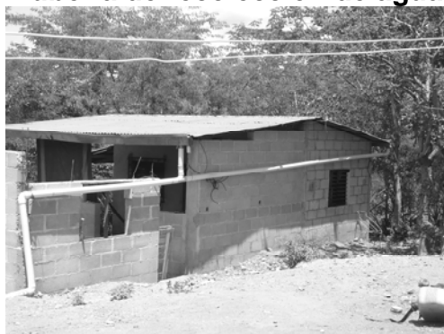
Figura 16. Tubería de recolección de agua de lluvia
