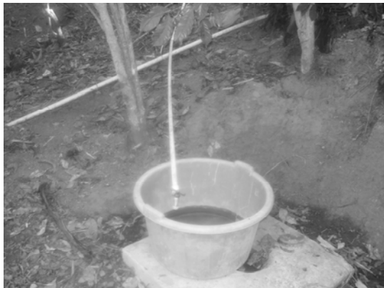
Figura 15. Extracción de agua de lluvia del aljibe
