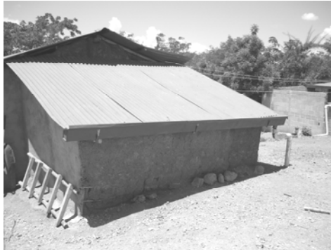
Figura 17. Superficie de captación de agua de lluvia
