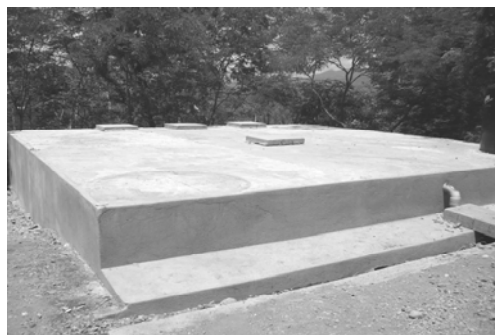
Figura 18. Aljibe colectivo de concreto armado
