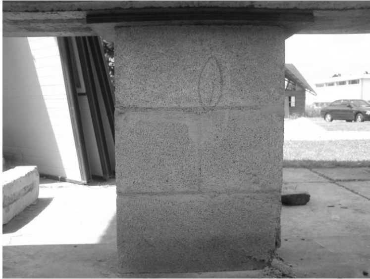
Figura 17. Ensayo resistencia a la compresión efectuado a prismas de mampostería
