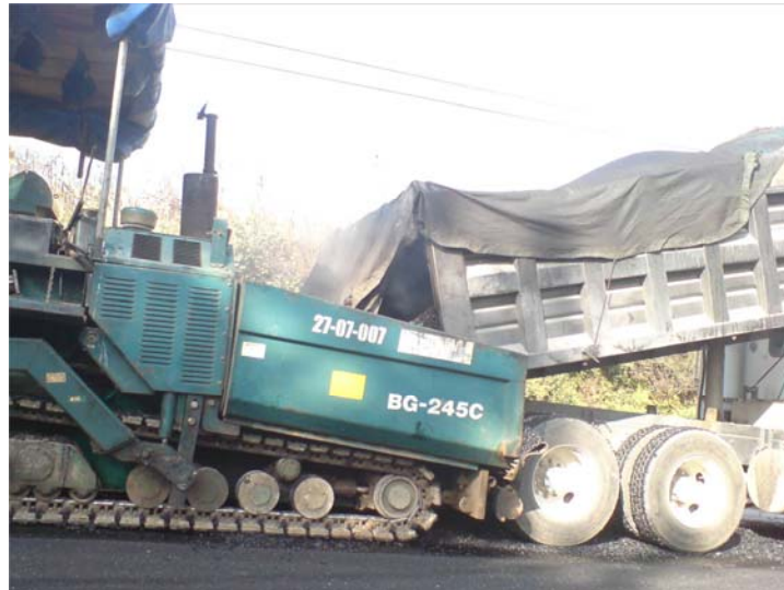
Figura 21. Extensión de mezcla drenante
