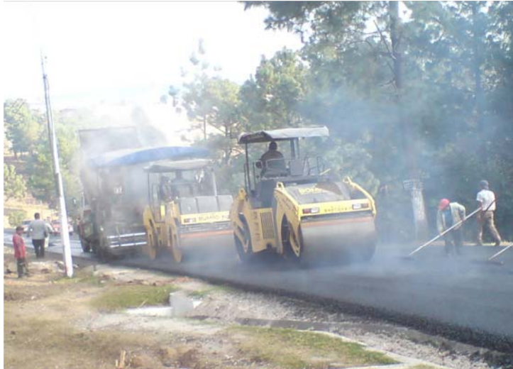
Figura 22. Compactación de mezcla drenante
