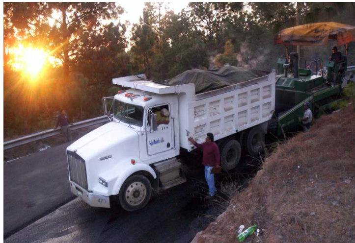
Figura 20. Transporte adecuado de mezcla drenante
