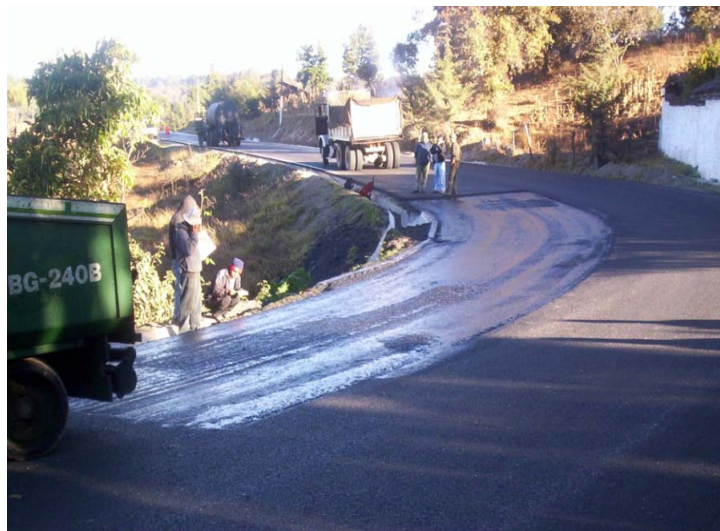
Figura 19. Aplicación de riego de liga
