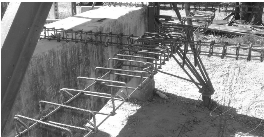
Figura 32. Armado de acero de refuerzo.
