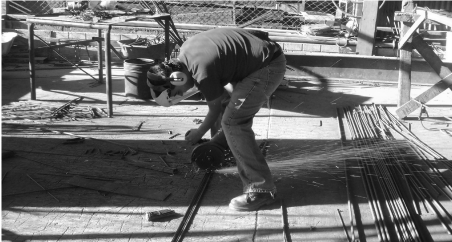
Figura 31. Corte de varillas de acero.
