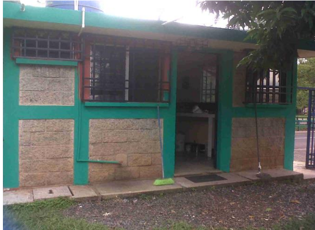
Figura 26. Instalaciones para almacenamiento y estancia de los vigilantes
