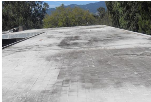
Figura 12. Estado actual losa edificio T-9
