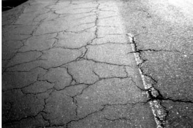
La figura 21 muestra un agrietamiento causado por el deterioro de la estructura del pavimento.
