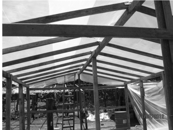
Figura 10. Instalaciones del vivero municipal 1
