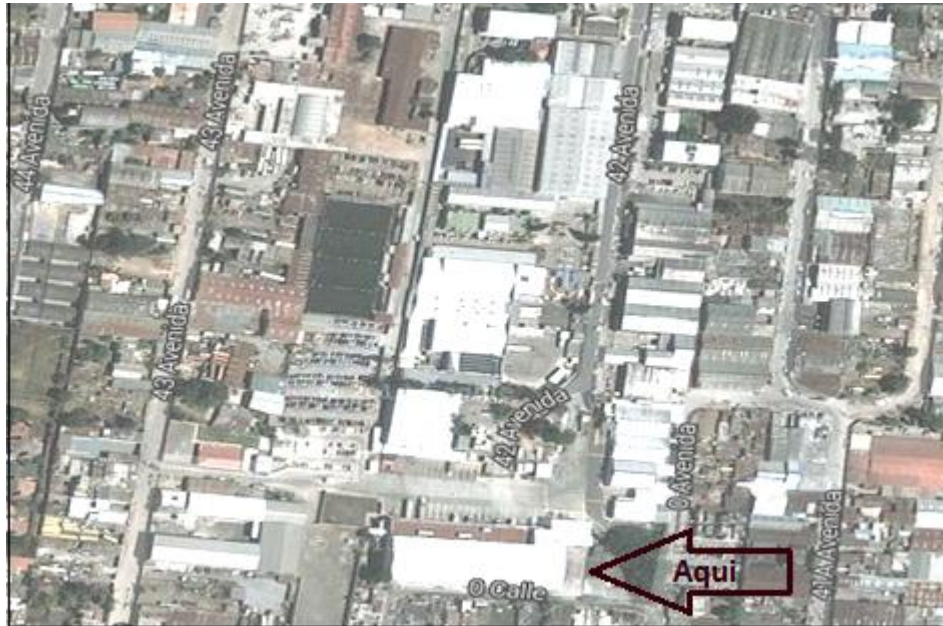
Figura 1. Vista aérea del Centro de Distribución
