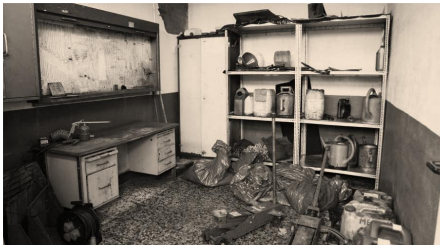
Figura 6. Condiciones de taller de reparaciones
