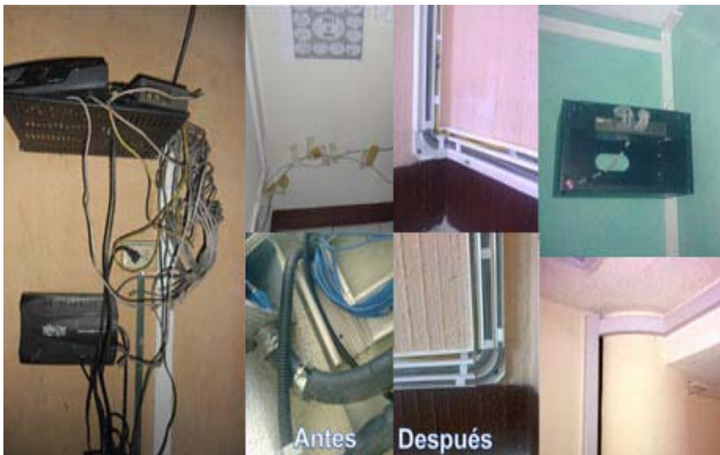
Figura 48. Mejores prácticas de cableado estructurado
