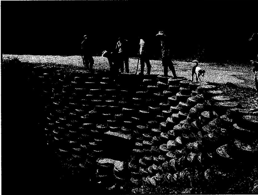
**Figura 36. Muro con llantas comunidad Toajlaj, Cuilco, Huehuetenango**
