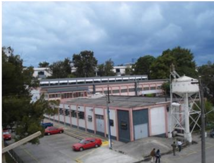
Figura 3. Centro de Investigaciones de Ingeniería
