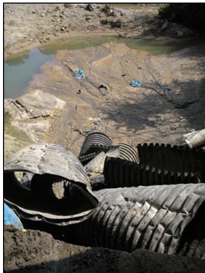
Figura 49. Gradación de alrededores de descarga de colector
