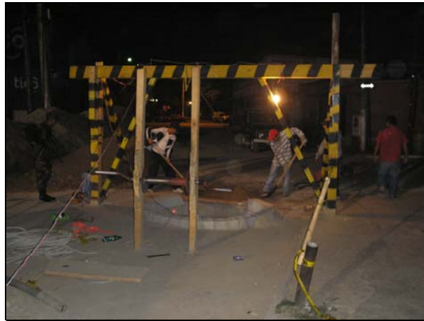
Figura 24. Uso del color en señalización nocturna
