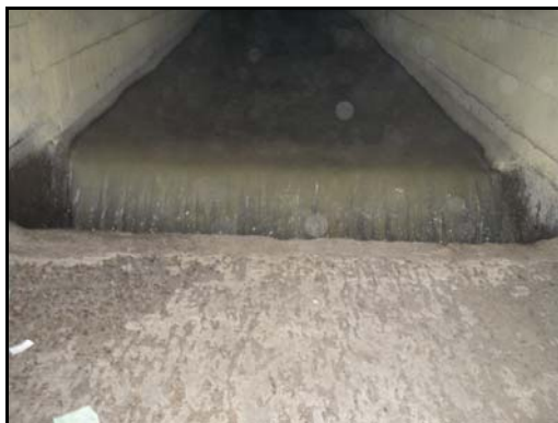
Figura 7. Derivador de caudal tipo salto
