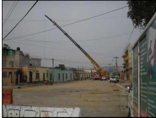
Figura 43. Uso de grúa de gran capacidad
