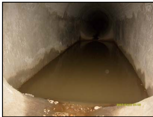
Figura 10. Disipador de energía con depósito
