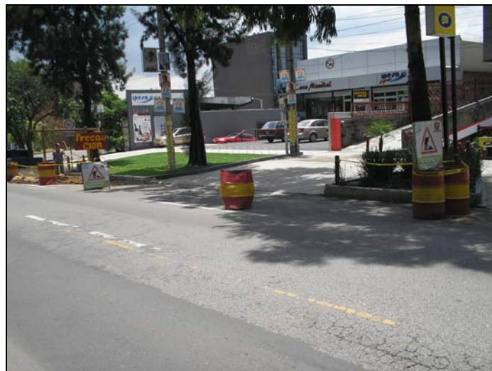
Figura 23. Señalización en vía pública
