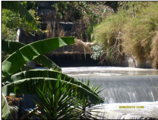
Figura 51. Vista frontal del disipador energía en descarga de colector
