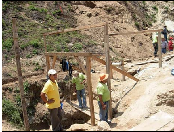
Figura 15. Instalación de marco de madera
