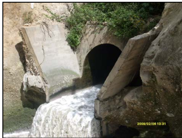
Figura 12. Cabezal tipo pared
