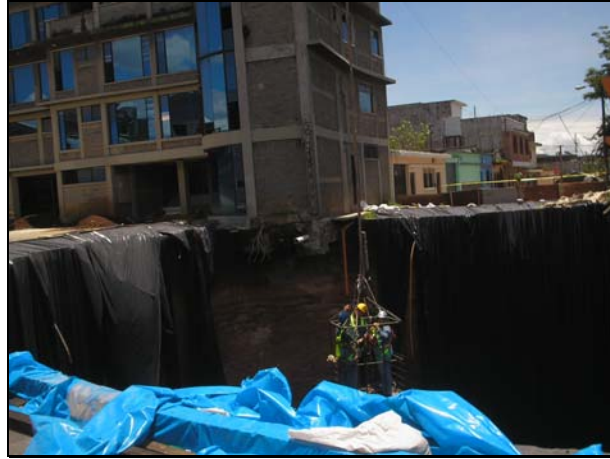
Figura 45. Ingreso a hundimiento utilizando grúa de gran capacidad
