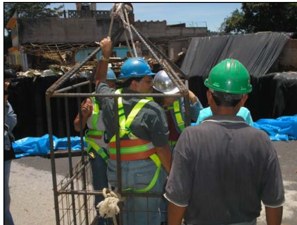
Figura 44. Uso de canasta metálica en inspección emergente en zona 6
