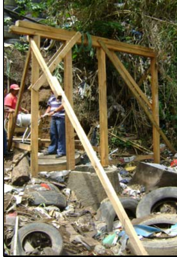
Figura 39. Instalación de marco de madera para inspección
