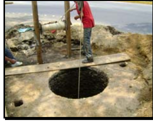
Figura 3. Ingreso a pozo de visita
