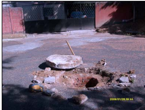
Figura 47. Remoción de tapaderas para favorecer la ventilación del sistema
