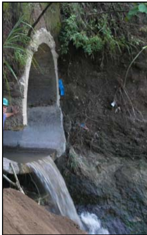
Figura 48. Ingreso de personal en descarga de colector principal
