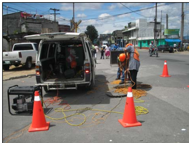
Figura 46. Equipo y herramienta utilizados durante inspección de registros
