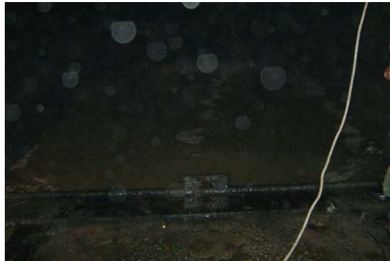
Figura 40. Manipulación de rejilla de derivador de caudal
