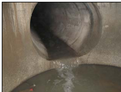
Figura 4. Depósito en pozo de registro
