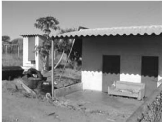
9. Construcción de la caseta de control e instalaciones sanitarias
