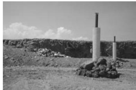
8. Preparación de drenajes de gas
