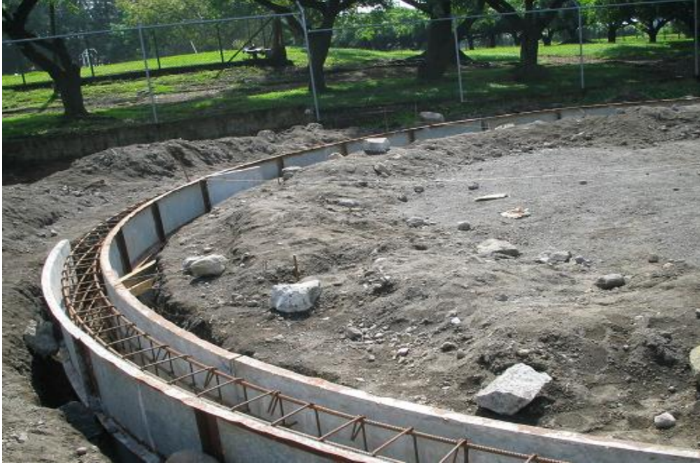
Figura 28 Cimiento de tanque anillo de concreto con refuerzo longitudinal y transversal ubicado en la costa sur.
