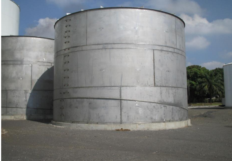
Figura 1. Tanque atmosférico cilíndrico superficial
