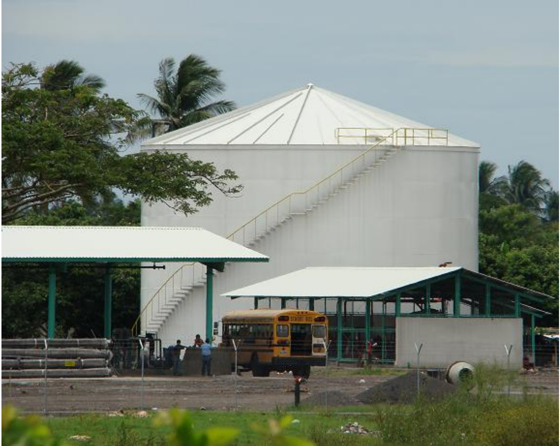
Figura 26 Tanque de Bio Etanol, ubicado en la terminal de exportación Puerto Quetzal
