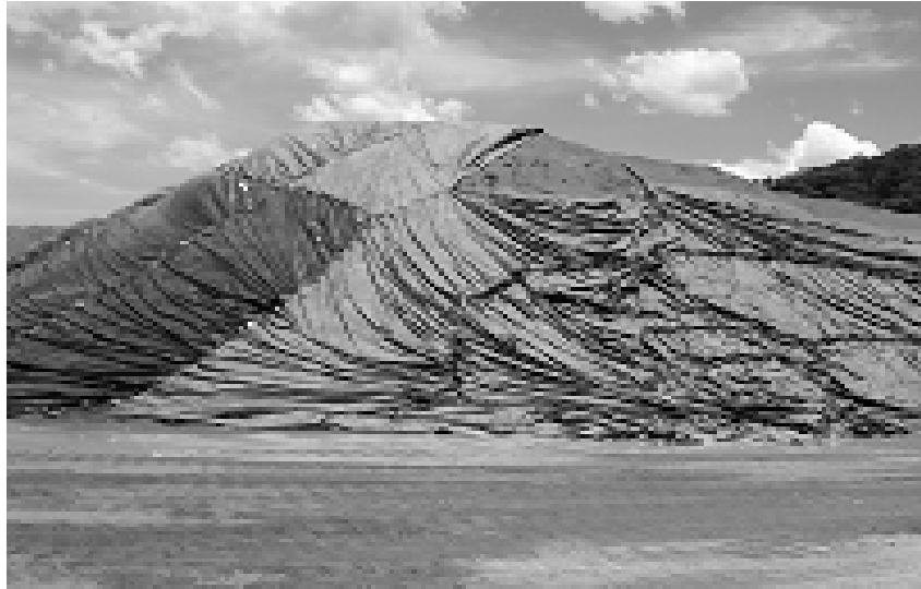
Apilamiento cubierto con nylon para evitar que material se sature
