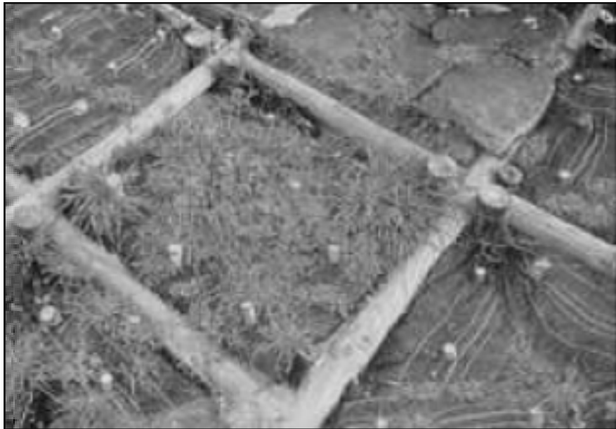
Figura 24. Detalle de la estabilización de taludes por cultivos
