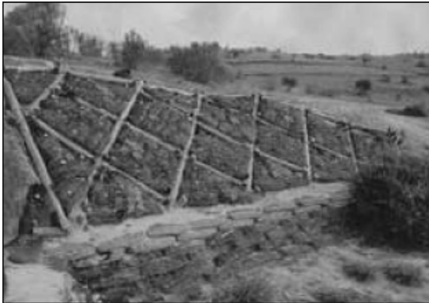
Figura 23. Ejemplo de la estabilización de taludes por cultivos
