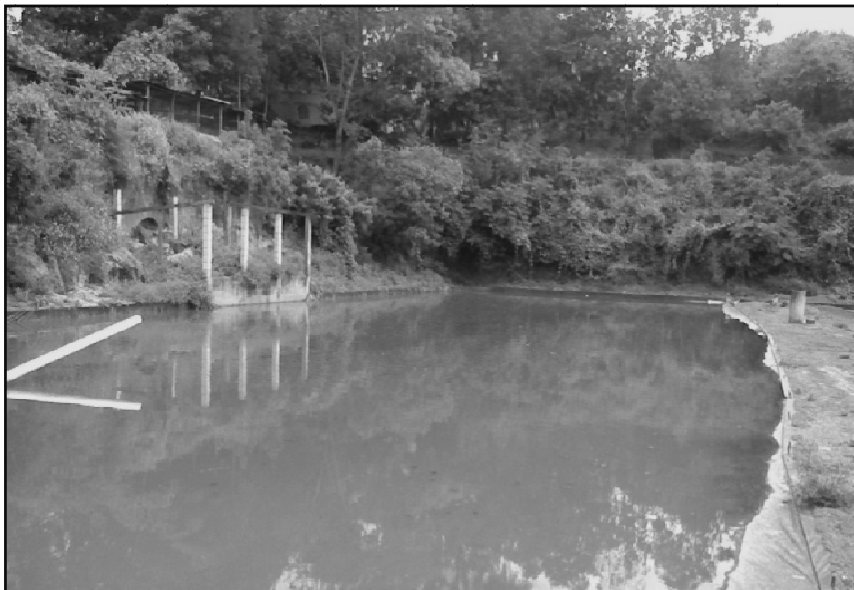
Figura 27. Lagunas de estabilización
