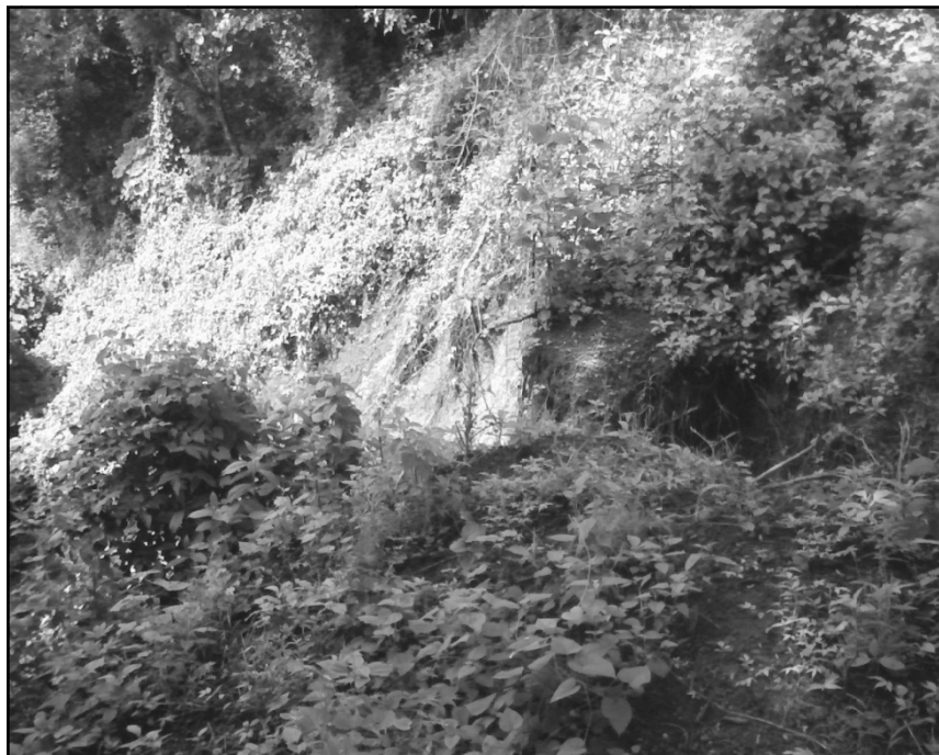
Figura 8. Talud con deslizamiento, vista desde la corona
