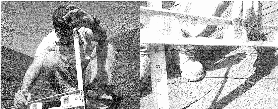
Figura 7. Determinación de pendiente con cinta métrica y nivel
