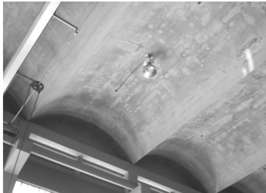
Figura 24. Luminarias edificio T-5
