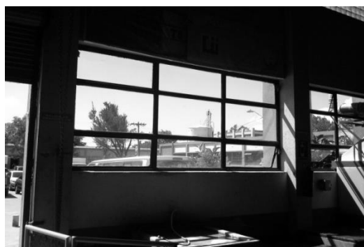
Figura 23. Ventanales edificio T-5
