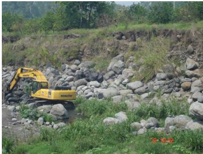
Figura 27. Proceso de extracción de material del río Guacalate, Planta Escuintla
